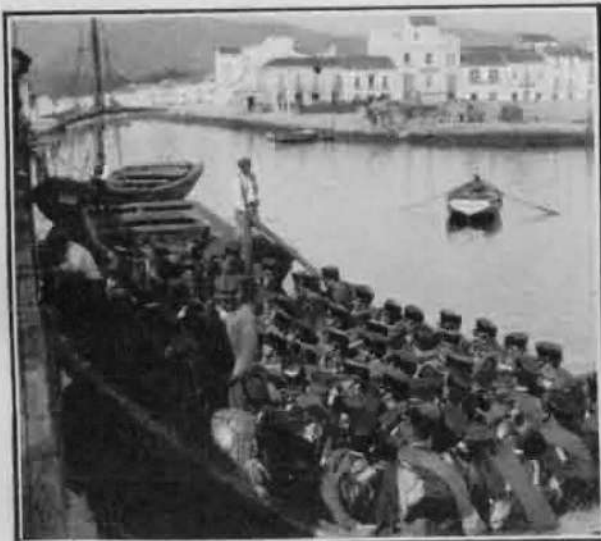
Embarque en el muelle de Algeciras de dos compañías de Ingenieros zapadores, compuesta de 400 hombres, que han sido enviadas á Ceuta
